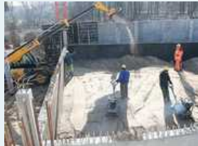
Basen buduje firma Alstal - Grupa Budowlana (wa)
